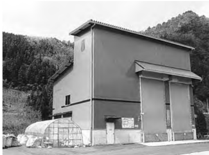
バイオマス発電所
