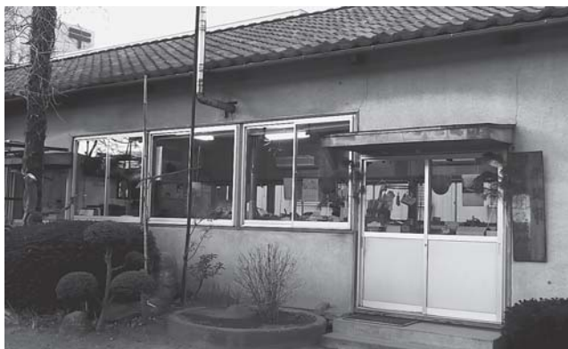
技能労務職員の職場である道路課分室
