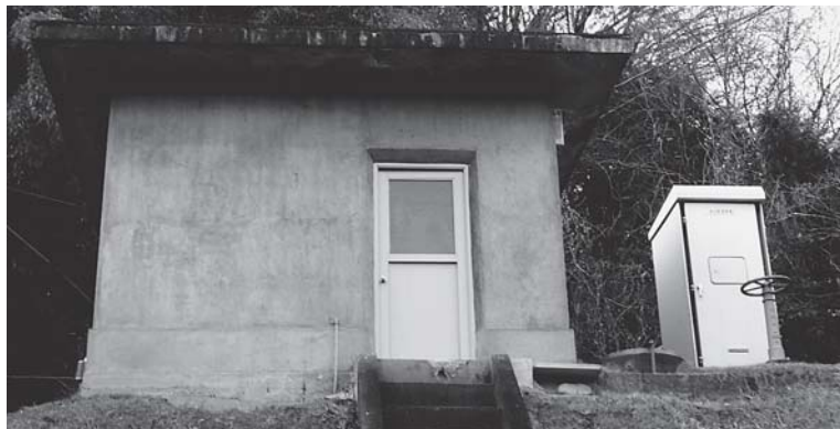
西岸低区送水ポンプ場
